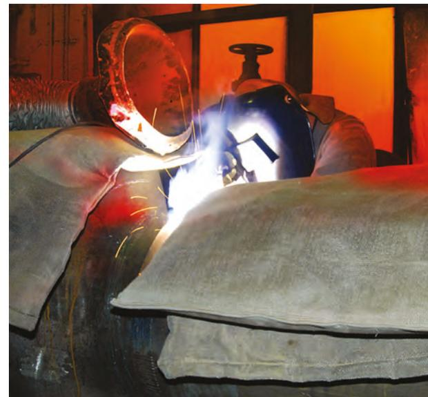
Tappeto imbottito per raffreddamento lento della saldatura, previene gli shock termici e protegge la saldatura dalle impurità. Cuciture rinforzate e tessuto esterno altamente resistente ad abrasione e scorie metalliche.
